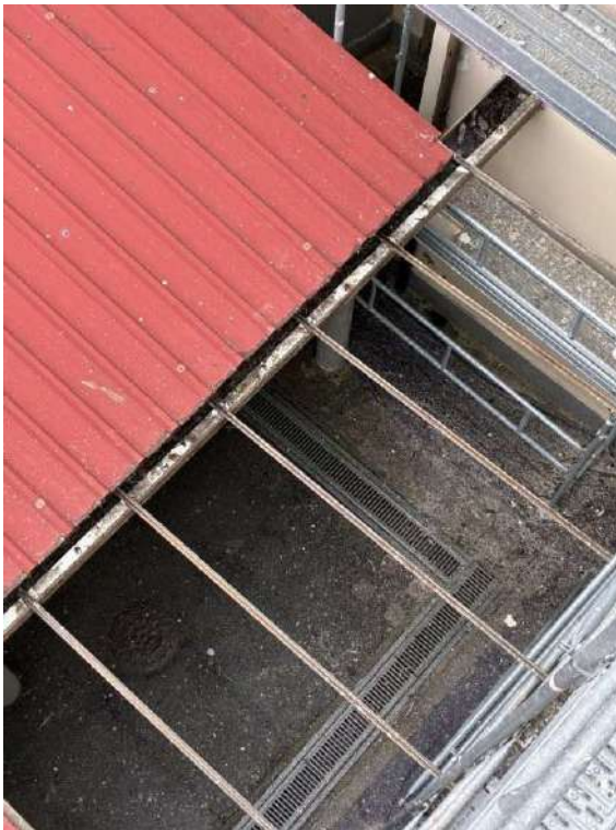
fotos – telheiro em painéis de policarbonato em mau estado de conservação
