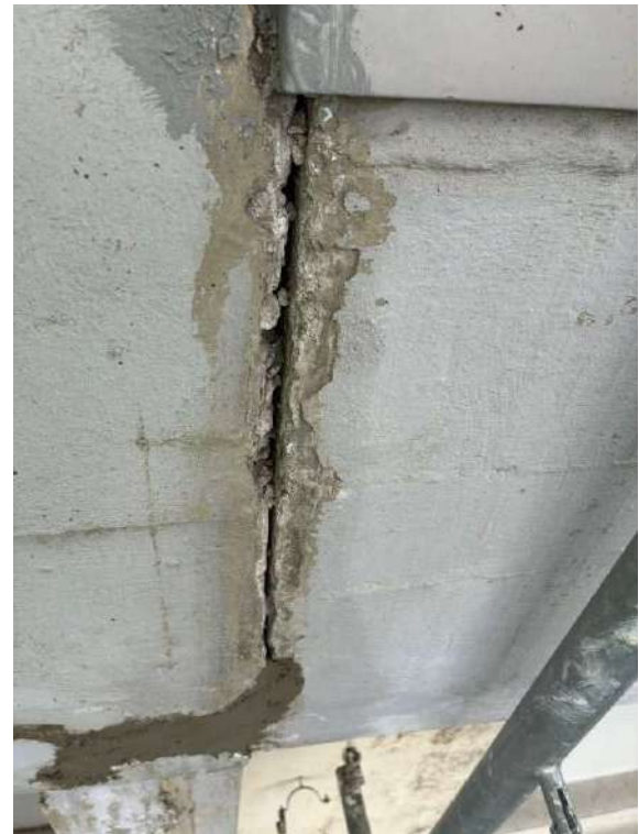
fotos – fissuração acentuada nos elementos de betão armado
