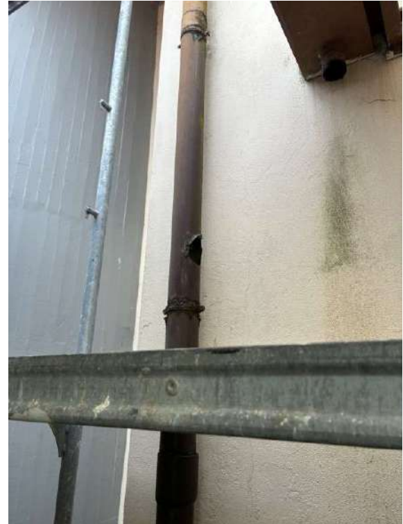
fotos – caleiros em chapa danificados e falta de tubagem de queda
