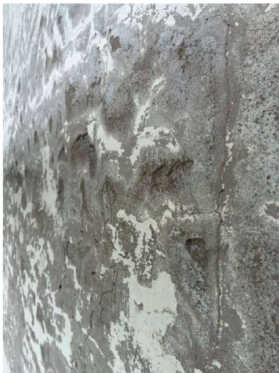
fotos – suporte para revestimento e acabamento final, reboco, em mau estado de conservação
