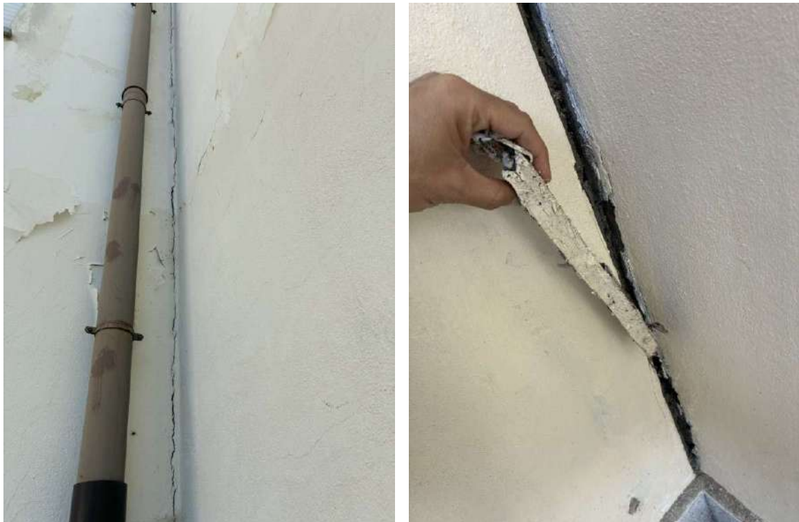
fotos – juntas de dilatação existentes nas fachadas do edifício
