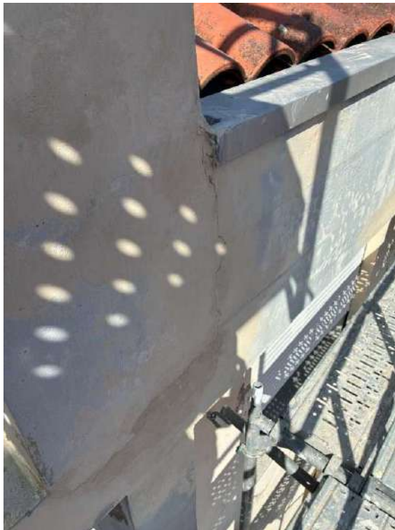
fotos – fissuração acentuada nos elementos de betão armado
