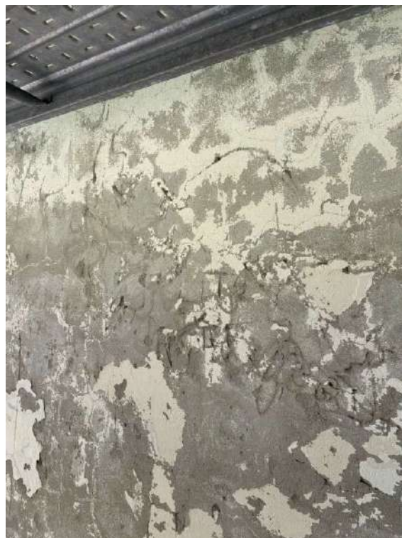
fotos – suporte para revestimento e acabamento final, reboco, em mau estado de conservação
