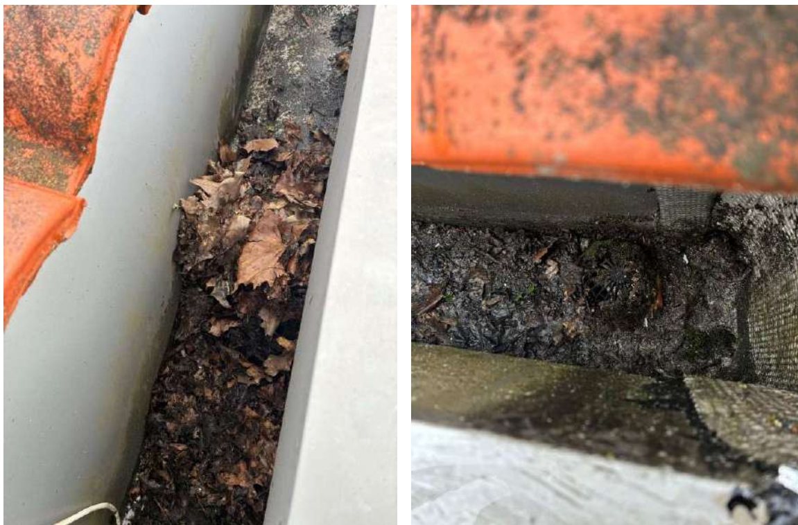
fotos – caleiros de águas pluviais em cobertura obstruídos
