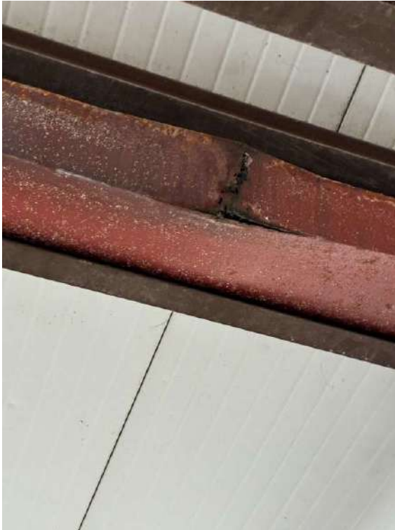
fotos – caleiros em chapa danificados e falta de tubagem de queda
