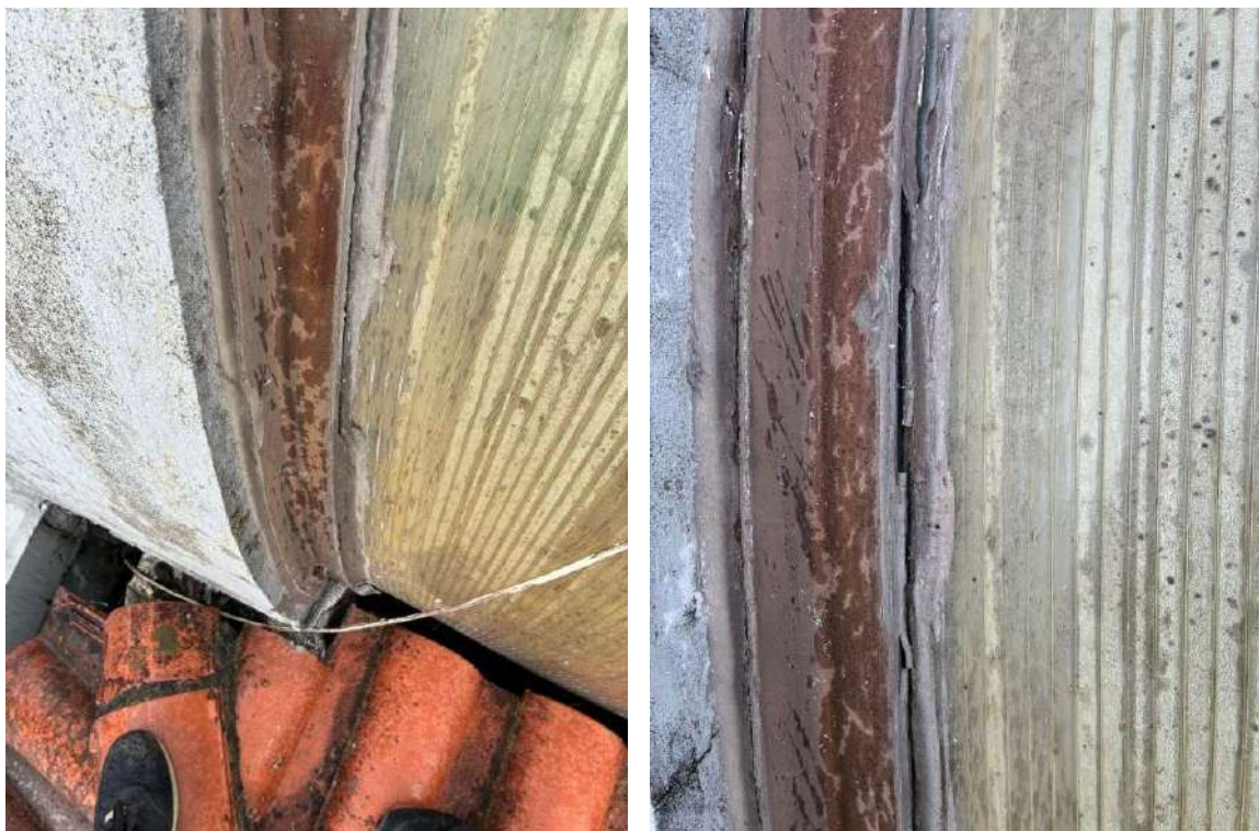
fotos – incorrecta vedação de painéis translúcidos existentes
